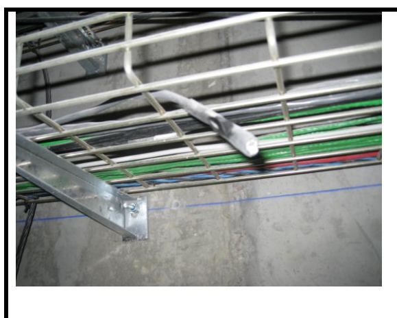
Incidencia 43 Cables colgando del techo sin regiband
