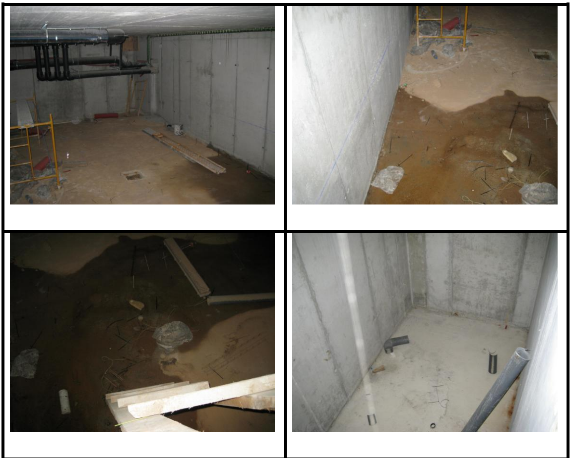
Incidencia 56 y 57 Entre en sector III y el sector IV, los huecos de los aljibes están sucios y con goteras
