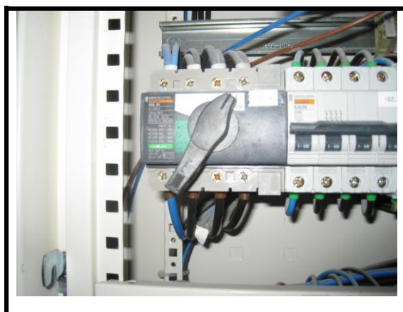
Incidencia 170 Cableado sin marcar RST
