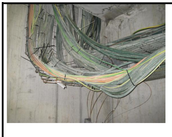
Incidencia 17 Cables mal instalados, fuera de regiband
