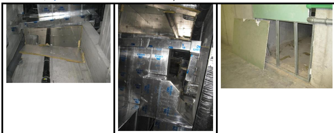
Incidencia6, 7 y 8 Dos conductos en mal estado y una entrada al hueco en mal estado
