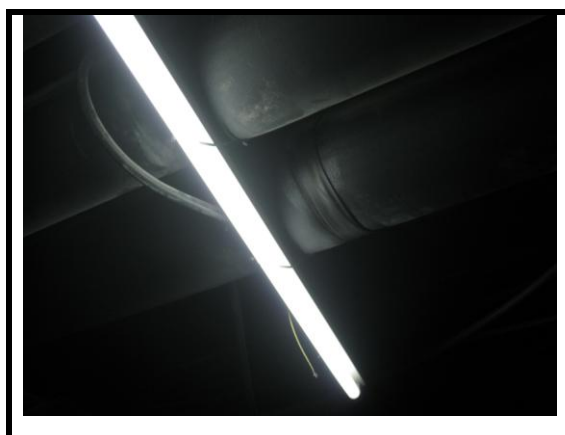
Incidencia 122 Luminaria del pasillo del túnel atada con bridas
