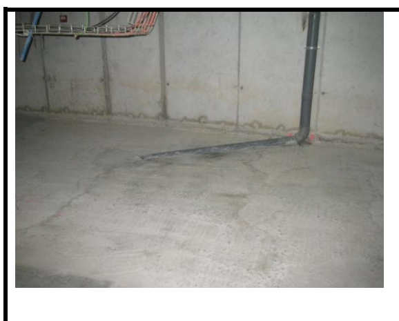
Incidencia 11 Falta desagüe en pasillo
