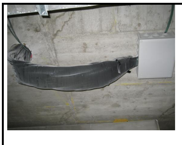
Incidencia 43 Cables colgando del techo sin regiband
