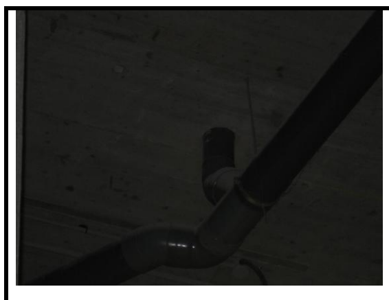
Incidencia 160 En el techo del gimnasio falta embocadura de desagüe
