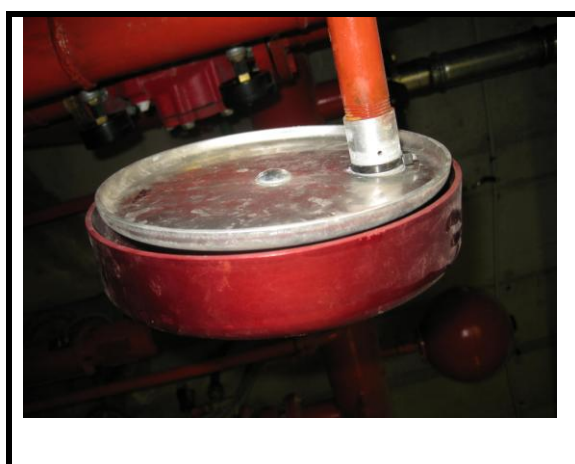
Incidencia 39 Campana sirena contra incendios en mal estado
