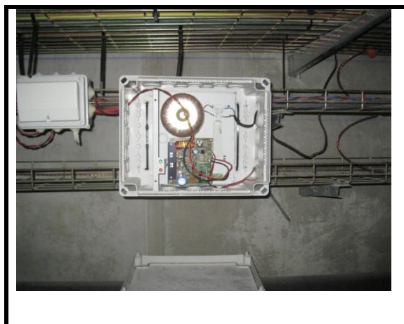
Incidencia 39 Campana sirena contra incendios en mal estado
