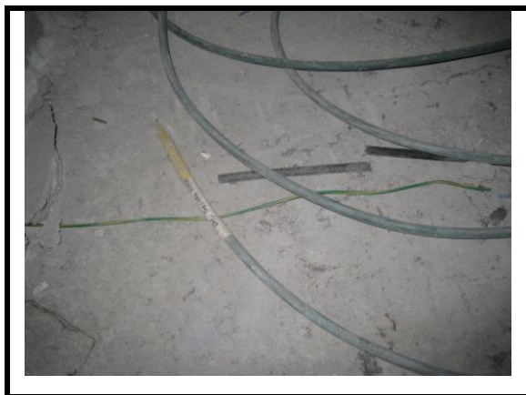
Incidencia 97 Manguera sin conectar
